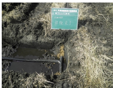
湧水処理工と補助孔工の完成状況
