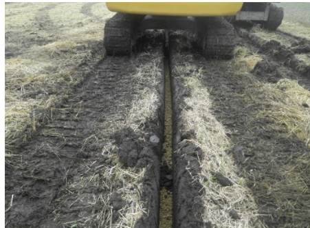
④-1 湧水処理の暗渠管を支線に接続
